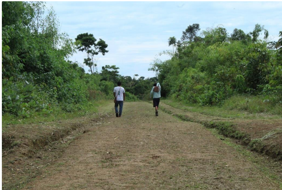
Figura 131: Cunetas tipo U del sistema de drenaje pluviales.
